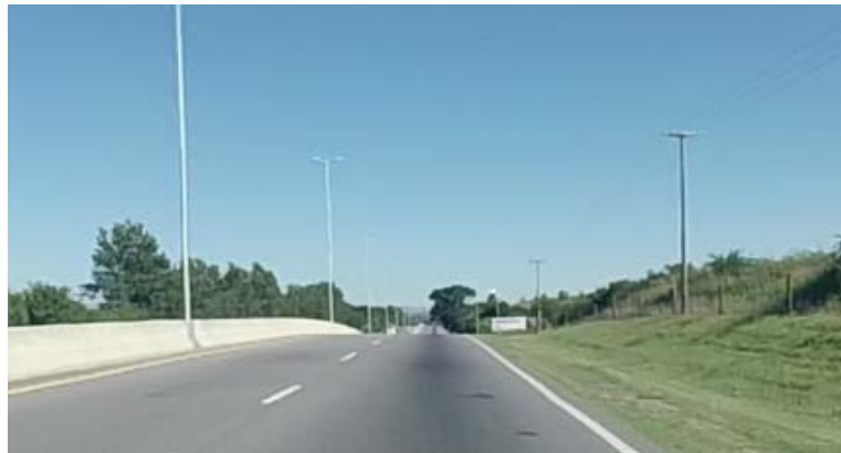
Foto 1. Pérdida de rasante (RP E-53, Córdoba)
