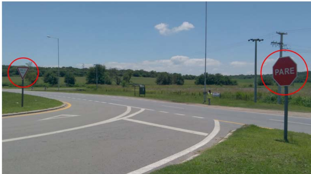
Foto 10. Señales incoherentes en un mismo punto (RP E-53, Córdoba)
