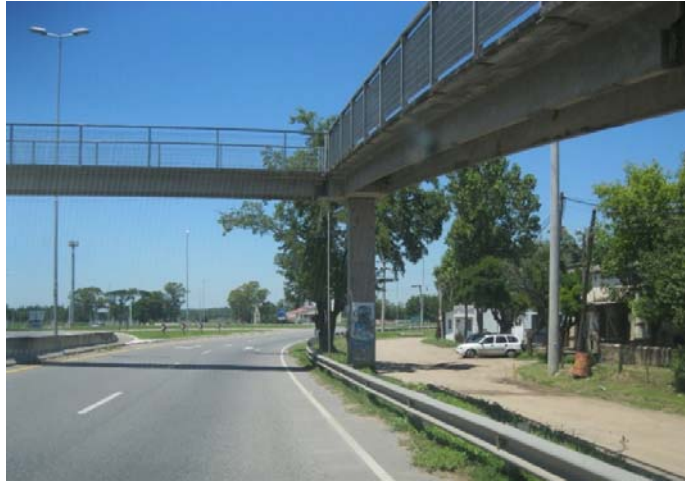
Foto 2. Estrechamiento de banquina por presencia de pilares (RP E-53, Córdoba)
