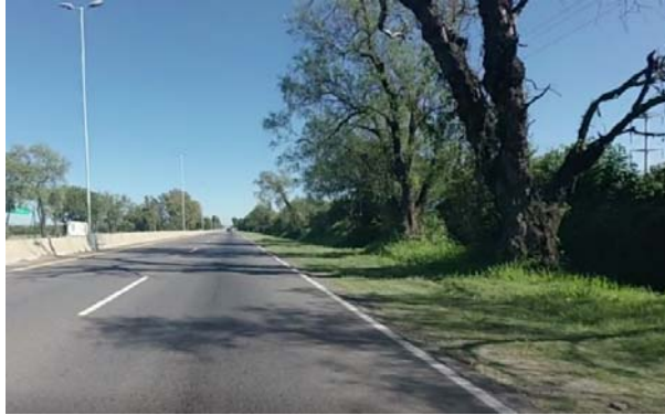
Foto 4. Árbol de gran tamaño próximo a la calzada (RP E-53, Córdoba)
