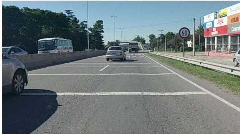
Foto 9. Señales contradictorias: Demarcación 40 Km/h y señal vertical de 60 Km/h (RP E-53, Córdoba)
